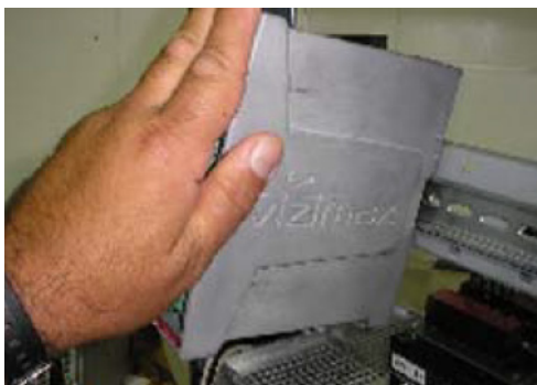
Figure 2 Montage du STCM sur rail DIN
